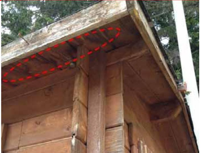
INCAPACITA' DI TENUTA STRUTTURALE E DISALLINEAMENTO INCASTRI DELLE PERLINE
