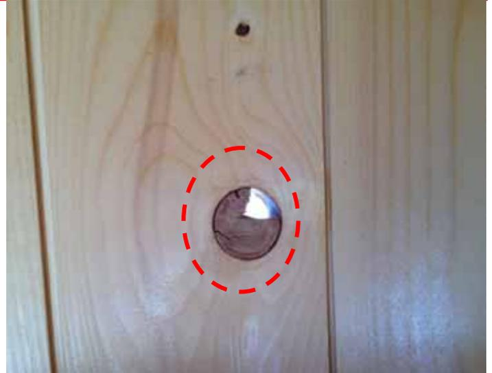
NECESSITA' DI INCHIODARE GLI ANGOLI: BASSA TENUTA STRUTTURALE ED AL VENTO, PIOGGIA ECC.
