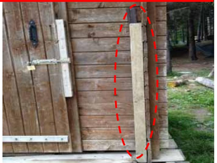
ROTTURE DELLE ASSI IN LEGNO A PERLINE SOTTILI CON PERDITA STRUTTURALE E RISCHIO INFILTRAZIONI ACQUA
